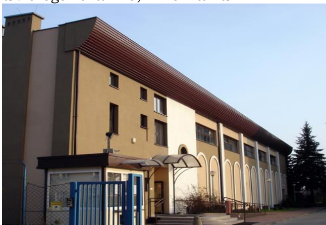
Hala Centrum Sportu i Rehabilitacji "Poznańska Szarotka" ul. Głogowska 145, w Poznaniu
